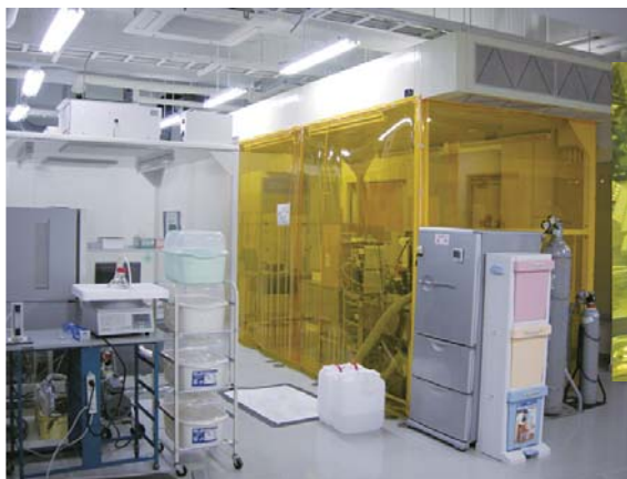
写真1 クリーンブースの設備 (化学試料棟208)
