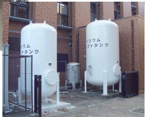
写真3 バッファータンク 10m 3 (右) 及び5m 3 (左)
