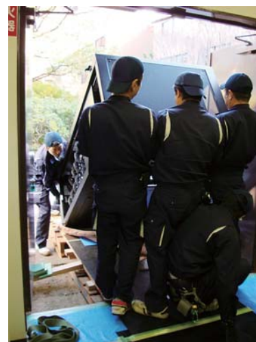
搬入口より背が高い機器は、結局人力で斜めにして入れました
