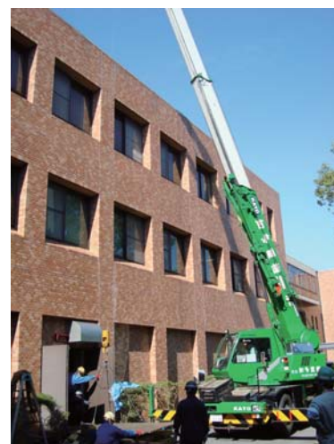
重量級機器の搬入にはクレーンが使われました
