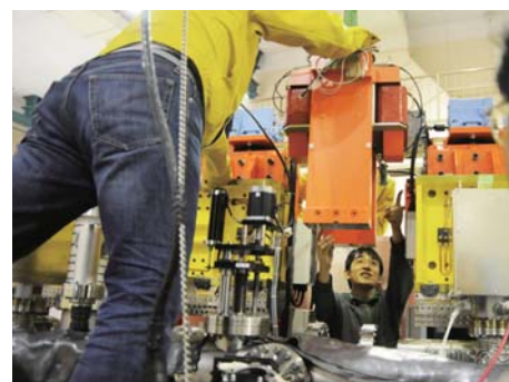
写真5 パンチング用電磁石設置の様子
