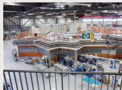
ホール中心シールド壁外観 (この中に加速器群が設置されています)
