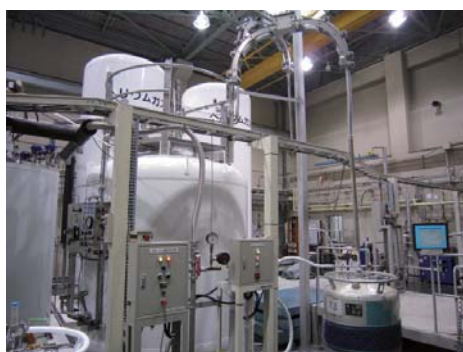
写真3 液体ヘリウム貯槽とH型トランスファチューブ
