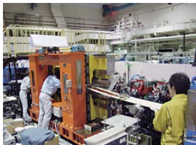
図5 設置作業の様子
